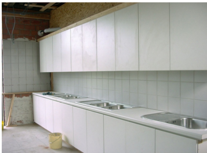
Deze oude huishoudelijke keuken voldeed niet langer aan de normen, en moest vervangen worden door een industriële keuken
