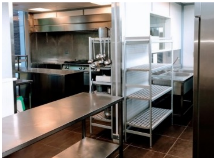
De verschillende onderdelen van de keuken worden van elkaar gescheiden via valse wanden
