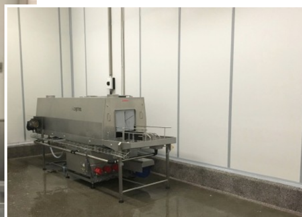
De bakkenwasruimte is gerenoveerd met polyester Becopanelen
