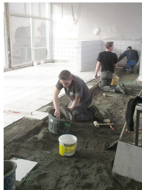
Voor de vloer werd een keramische tegel gekozen die de leerlingen van tso Bouw zelf legden
